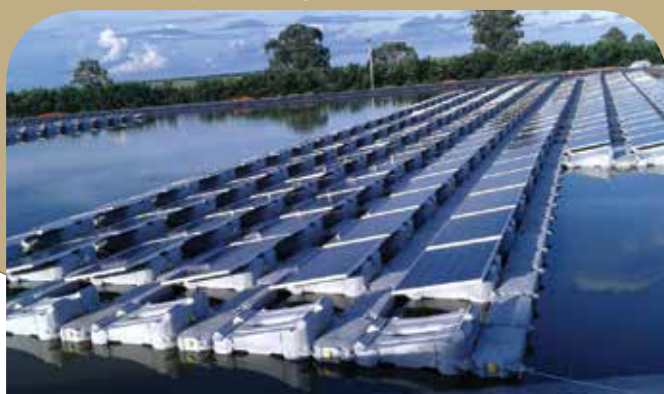
Placas solares em superfície de água
